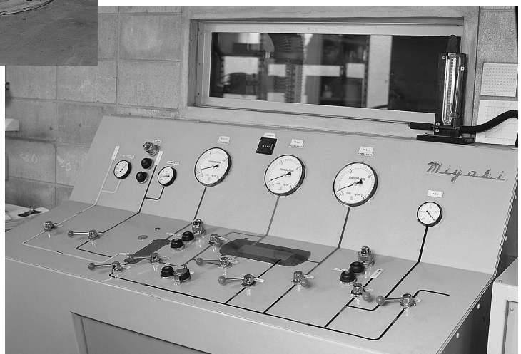
爆発引火強度用操作盤
